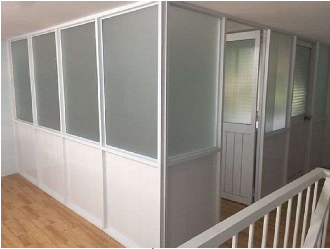
Phân chia phòng bằng khung nhôm cửa kính
